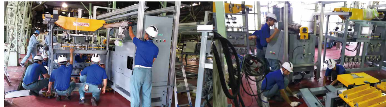
客先での搬入・据付作業
